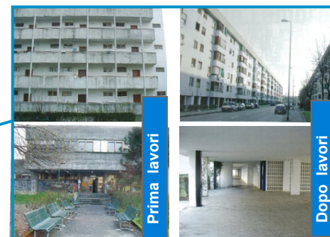
Intervento sugli edifici esistenti
