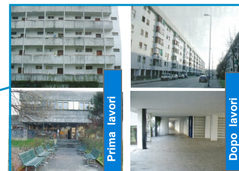
Intervento sugli edifici esistenti
